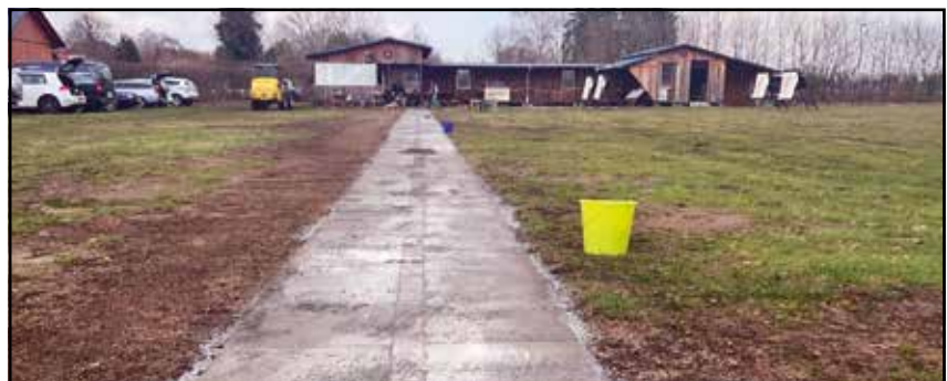
Die fertiggestellte Schießlinie mit dem Vereinsheim im Hintergrund
